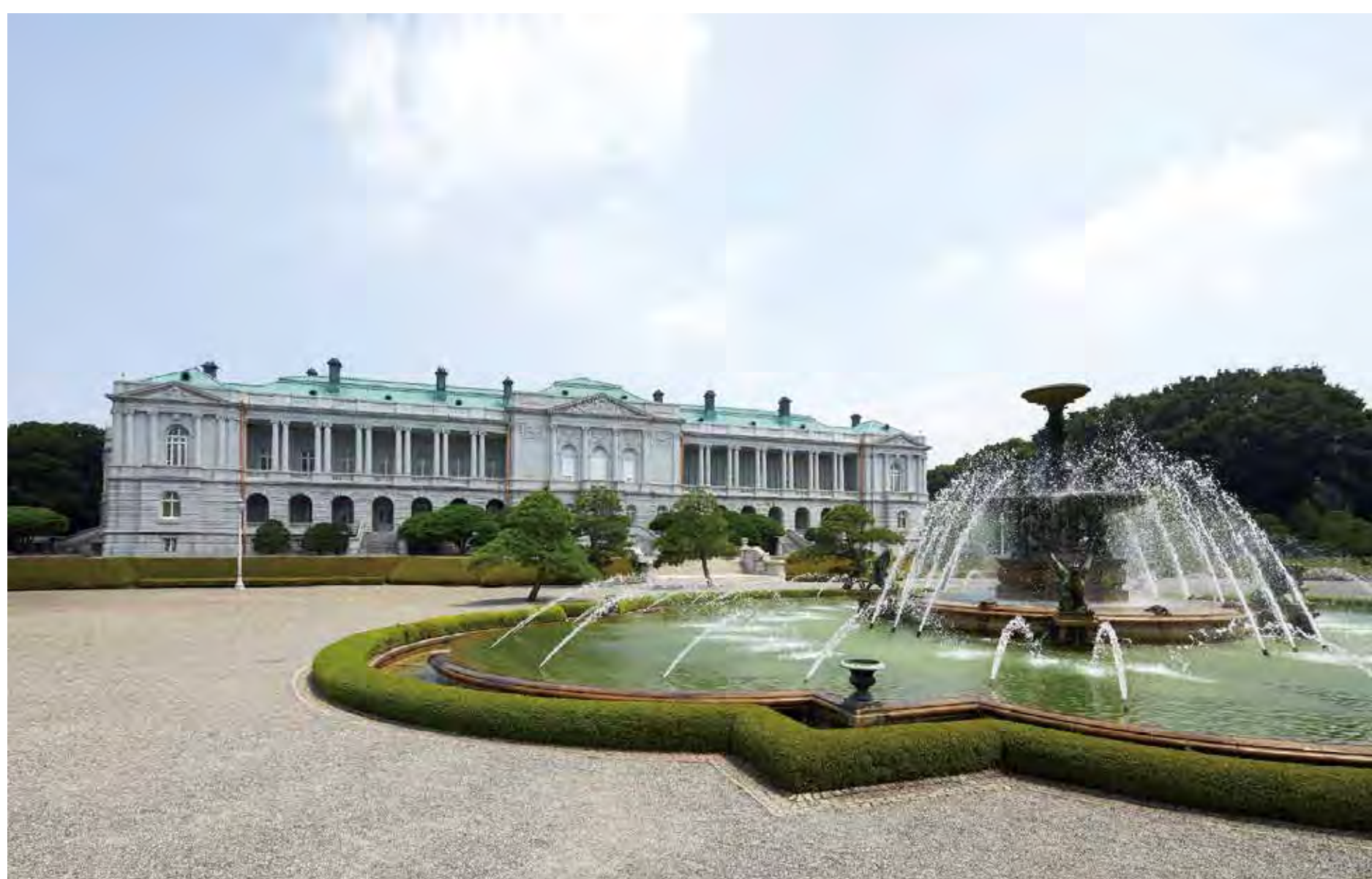
迫力が増すように既存の噴水のまわりに外池*を新設 *水があふれ出す淵からサツキの植栽までの部分
