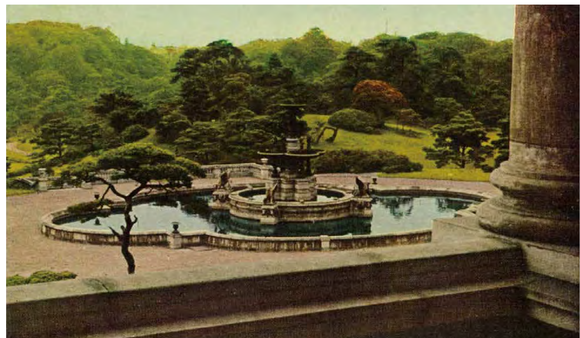
改修前 2階バルコニーより 絵葉書 庭園 個人蔵(長谷川怜氏 提供)
