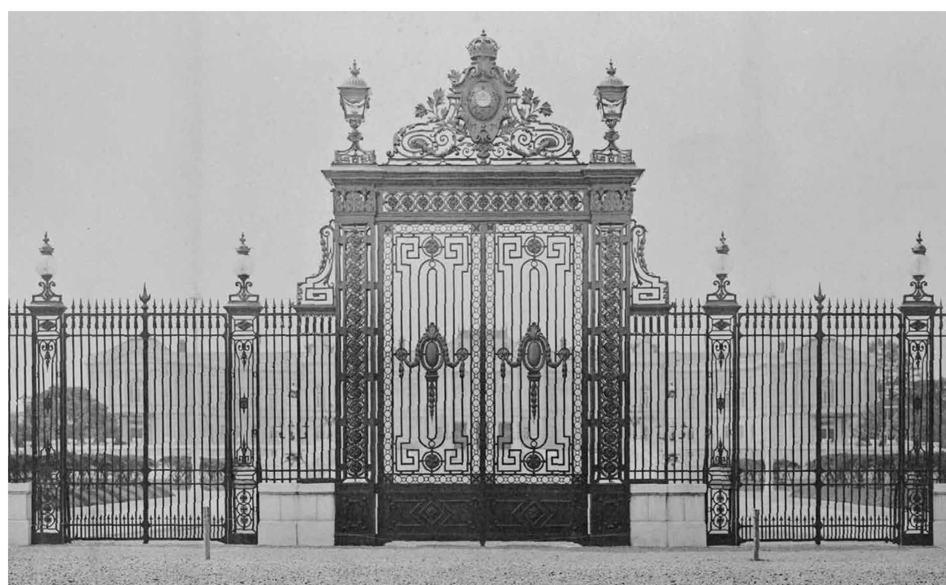
創建時の写真 正門上部の王冠は改修時には外されていました
