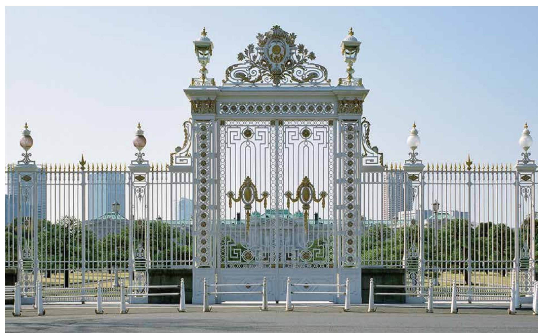
昭和の改修後
