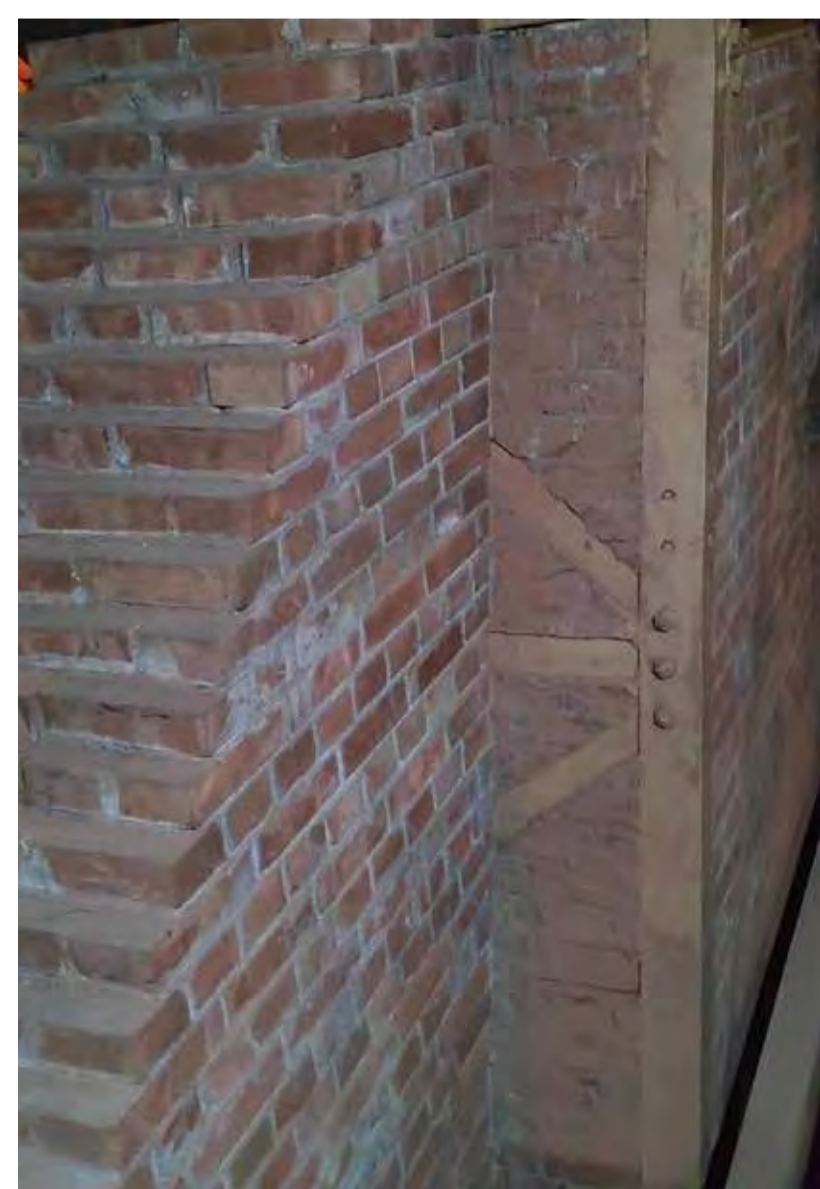
建物内部のレンガ積み
