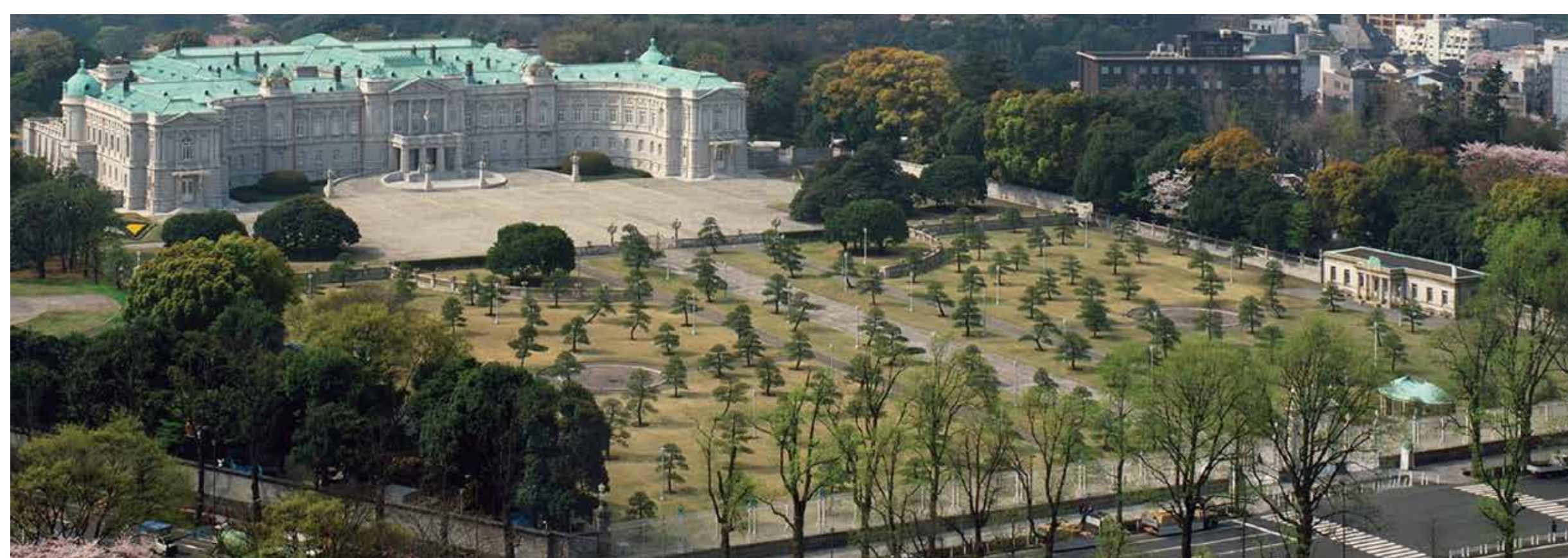
昭和の改修後
