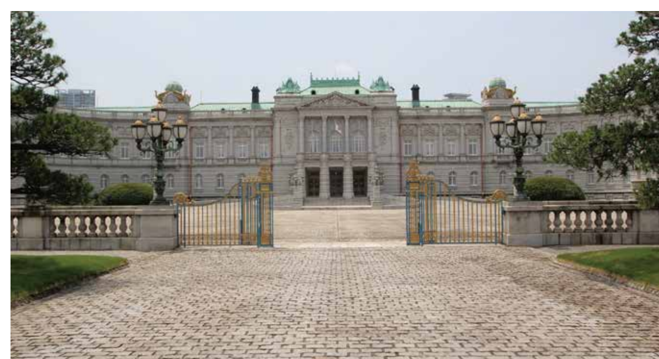
昭和の改修で新設された門庭と玄関庭を区切る中門
