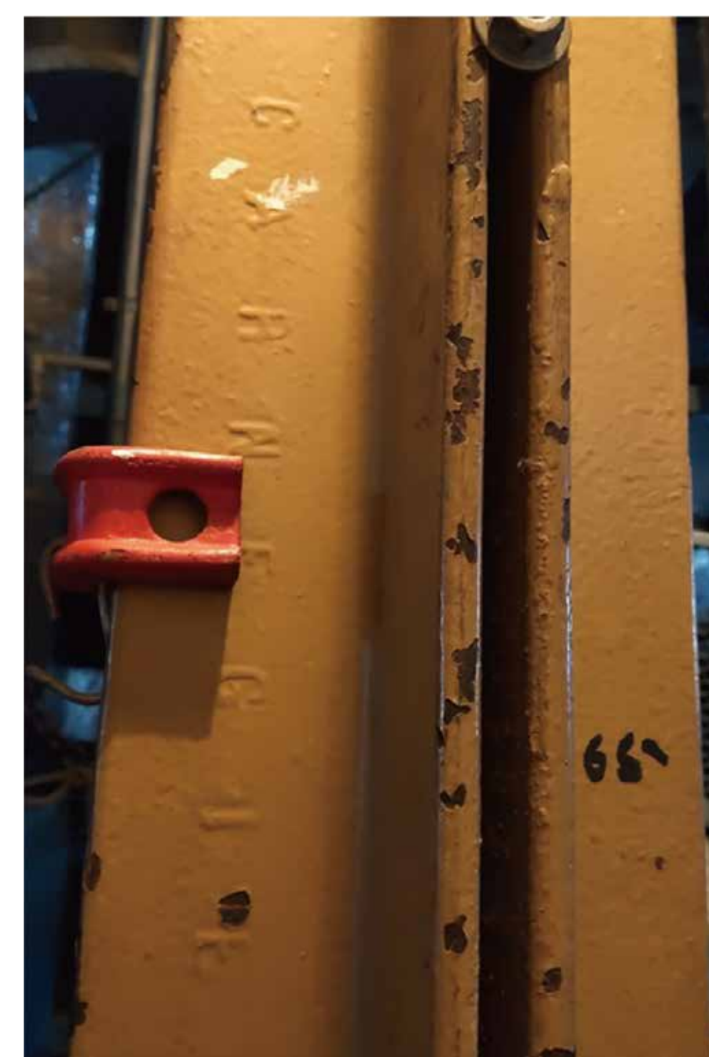
本館で使われている「CARNEGIE」（カーネギー）の刻印が入った鉄骨
