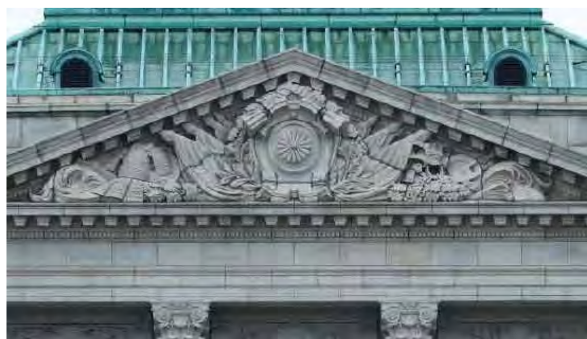
南北外壁面上部の三角形の壁(ペジメント)には鎧、兜の浮き彫り装飾
