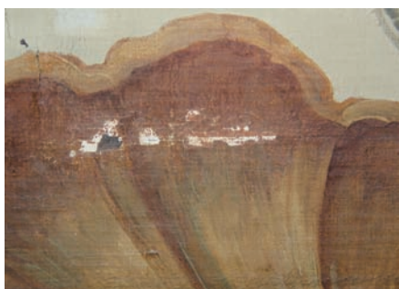
図16 意匠部分の剥落
