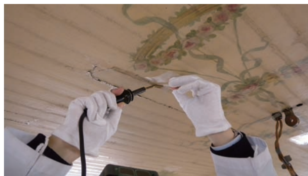
図3 接着作業：膠水を筆で差し入れる
