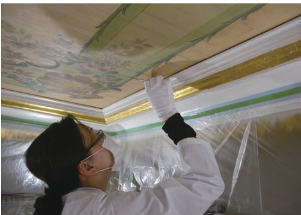
図2 汚れ洗浄作業
