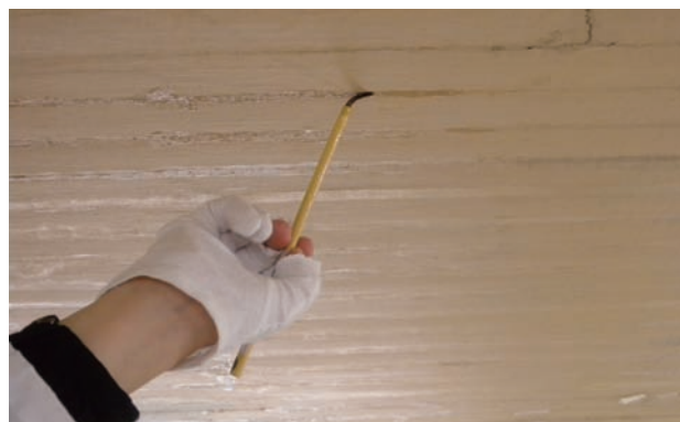
図3 接着作業：膠水を筆で差し入れる
