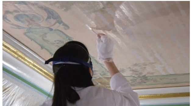
図5 充填整形作業：余分な充填剤を洗浄
