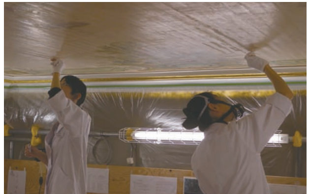
図4 充填整形作業：余分な充填剤を洗浄
