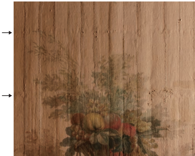
図26 木摺の段差による変形（斜光線画像）：縁周り（短辺）には長辺と直交する木摺があり、その段差が目立っている。
