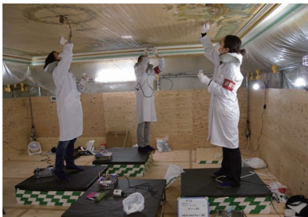
図2 接着作業：膠水と電気鋺で絵具層の浮き上がりを接着
