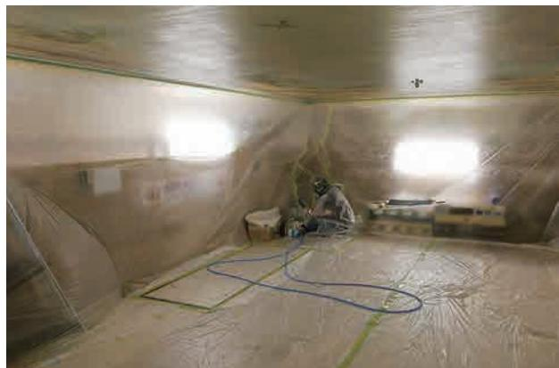
図2-141 壁面・床養生の様子
