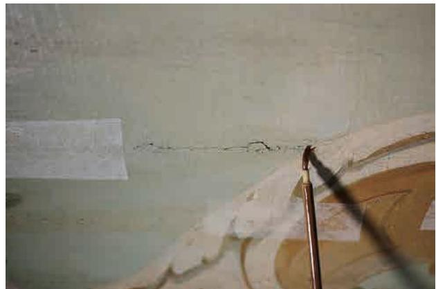
図2-48 損傷部分に膠水を染み込ませている様子
