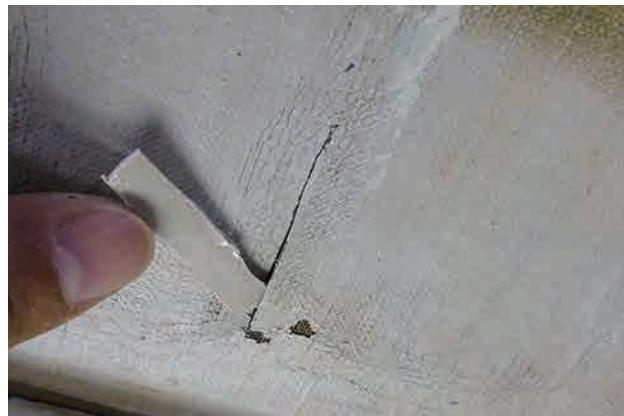
図2-104 充填処置の様子
