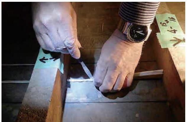
図2-99 木摺の隙間への処置の様子
