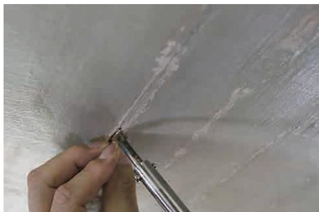
図2-108 充填材を充填する
