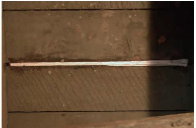
図2-100 木摺の隙間への処置後
