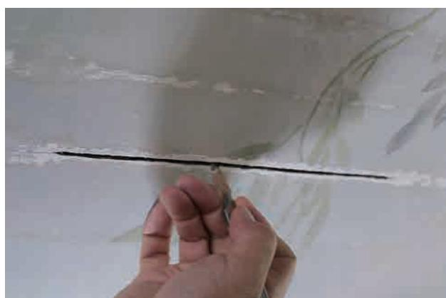
図2-106 旧充填材を除去した様子
