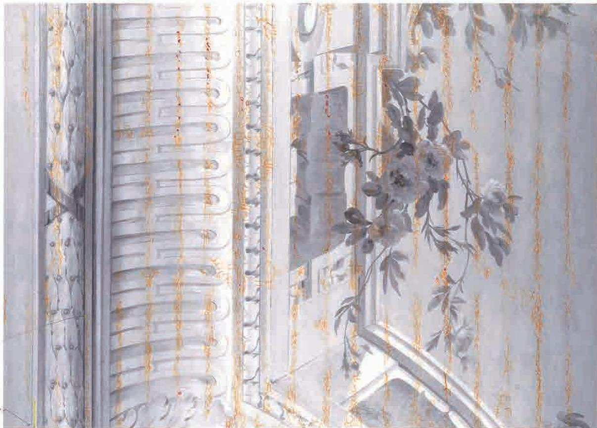
図2-14 ① 剥落・亀裂・破れ、穴。記録表には通常光写真を使用した。
