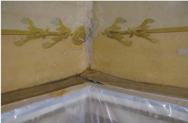
図2-4-51 修復中 (F6) 廻り縁の上端で、キャンバスの端がガムテープで接着されていた。
