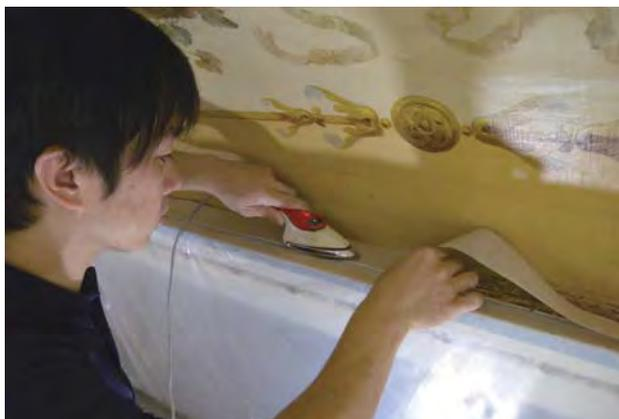
図2-4-61 用意した麻布を接着し、カンバス端を廻り縁の上端で固定した。
