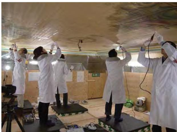
図1-1-5 浮き上がり接着作業
