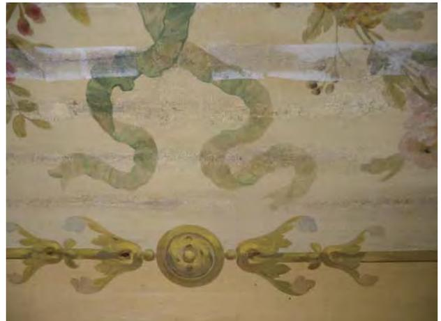
図 2-4-132 浮き上がり接着時の加温により旧処置のワックスがしみ出した部分
