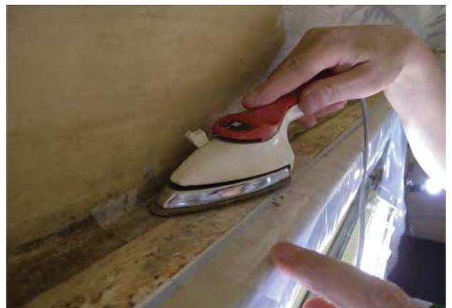
図2-4-56 接着剤除去後アイロンで加温し、キャンバス端の変形修正を行った。
