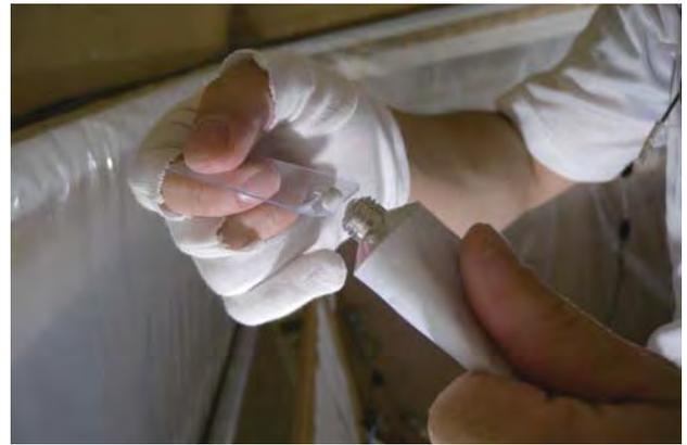
図 2-4-68 チューブに詰めた充填剤を充填整形用のフィルム状ヘラに取る。
