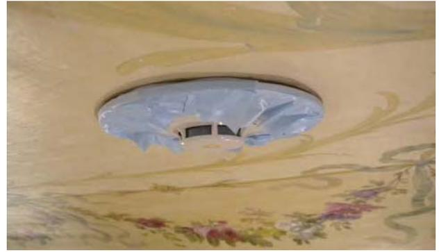
図2-4-86 ワニス塗布前の養生（火災報知器）
