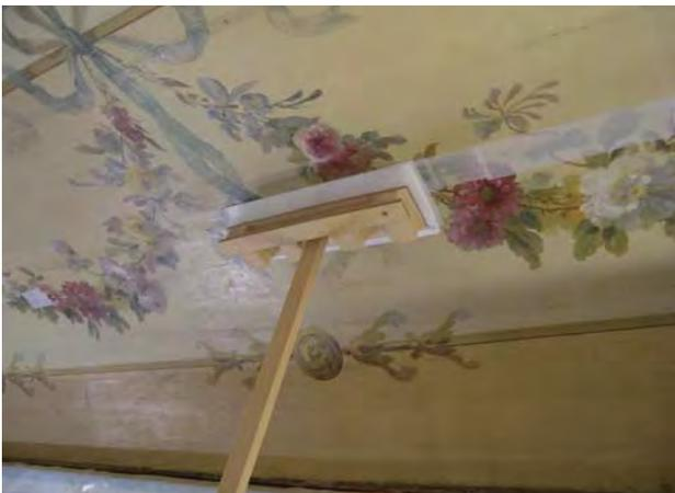
図 2-4-48 接着箇所へ緩衝材を当てて、乾燥するまでつかえ棒をして下から圧着した。
