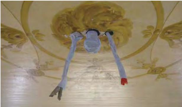
図2-4-87 ワニス塗布前の養生（シャンデリアの金具と電源コード）
