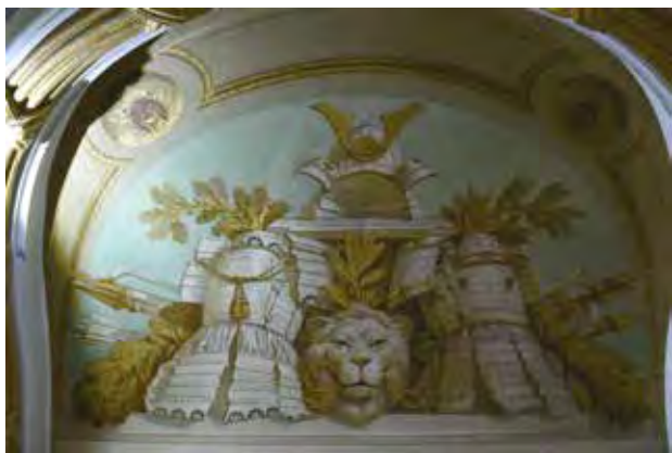
図 3-4-13 壁画 A-2 の中央部は、壁面と接触されていない。
