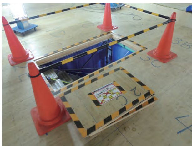
図4-1-2 仮設足場ステージ出入口
