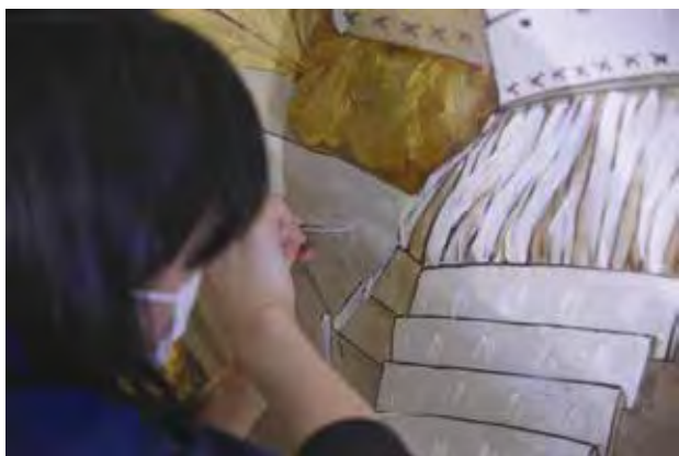
図 3-4-14 剥離部に膠水（17%）を注入した。
