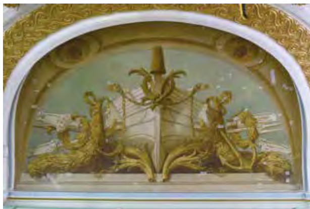
図3-4-2 壁画 A-3 浮き上がり接着後
