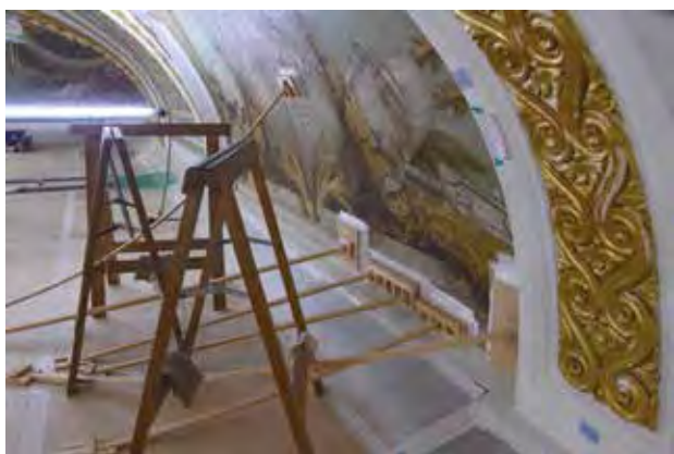
図 3-4-16 壁画 A-1 圧着作業
