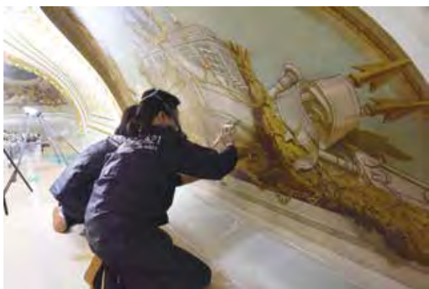
図 3-4-24 保護ワニス塗布作業
