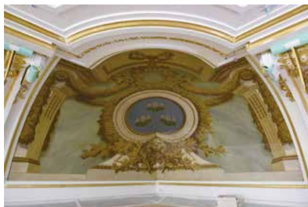
図3-4-8 洗浄途中 画面右下が洗浄済み
