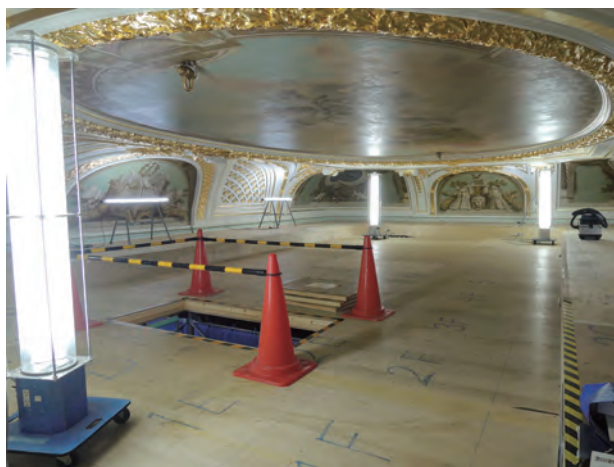
図4-1-1 仮設足場ステージ上
