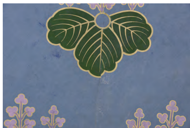
図3-2-42 テープの形に合わせて細かい剥落が生じている。
