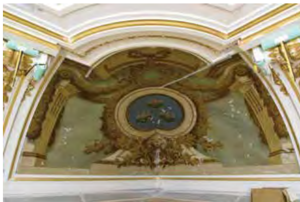
図3-4-3 壁画 B-3 浮き上がり接着後
