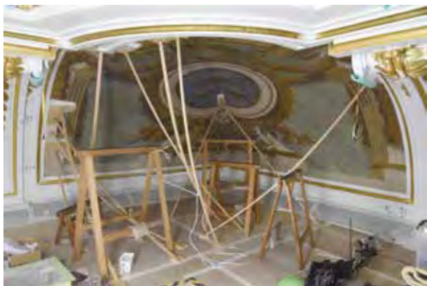
図 3-4-15 壁画 B-1 圧着作業
