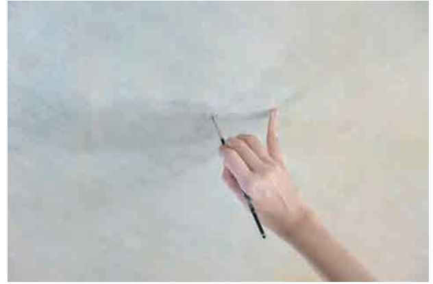
図2-4-83 下地基本色塗布後、周囲の色味に合わせて補彩した。
