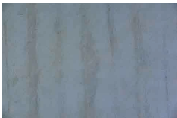
図2-2-52 天井絵画 修復前 絵具層の亀裂 通常光写真
