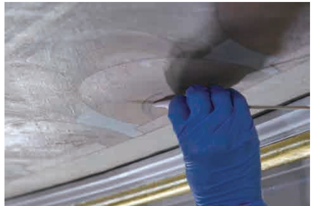
図 2-4-34 除去できずに残った旧補彩は、希アンモニア水を用いて除去した。
