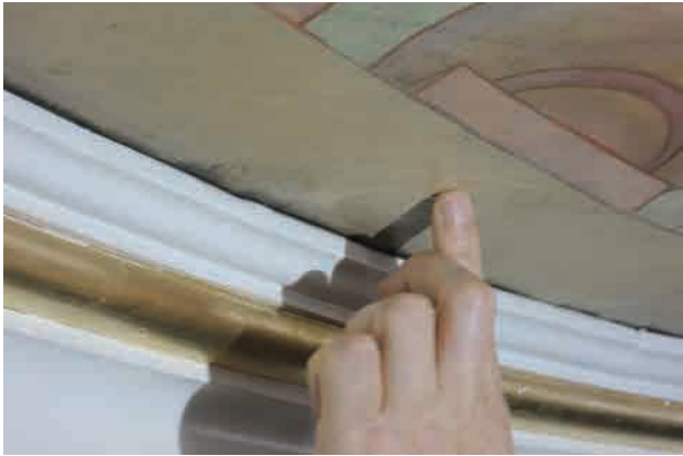
図 2-2-65 表面にはべとつきはなく、安全に除去ができた。
