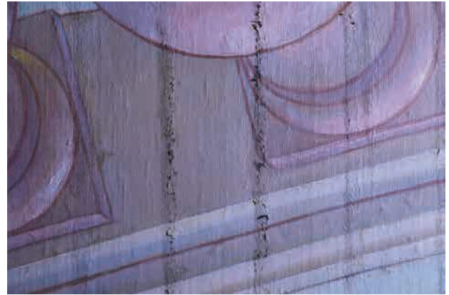
図 2-2-67 浮き上がり接着前
