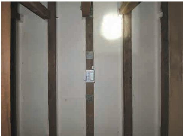
図 2-2-2 小屋裏 天井絵画裏面
