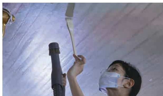
図 2-4-11 浮き上がり接着前の乾式洗浄
