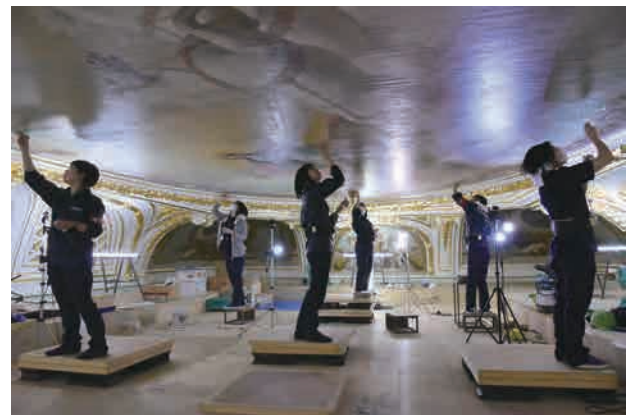
図 2-4-70 充填整形作業風景
