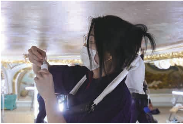
図 2-4-65 チューブに詰めた充填剤をヘラに取る。
