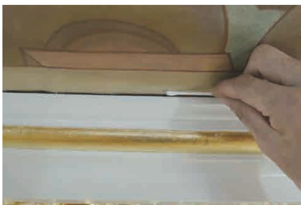
図 2-4-106 廻り縁付近には、塵埃や汚れの付着は認められない。
