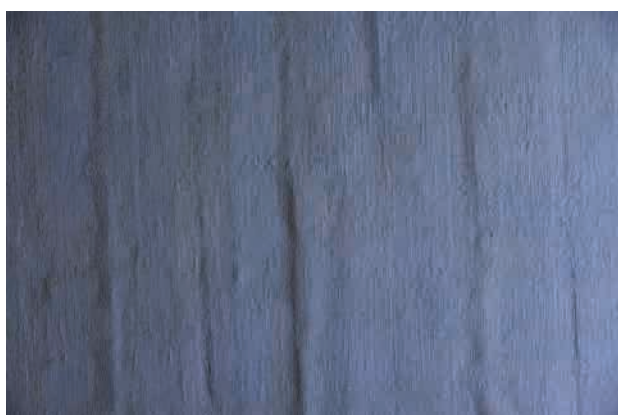
図2-2-53 天井絵画 修復前 絵具層の亀裂 側光線写真
