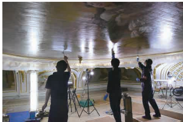
図2-4-76 保護ワニス塗布作業風景
