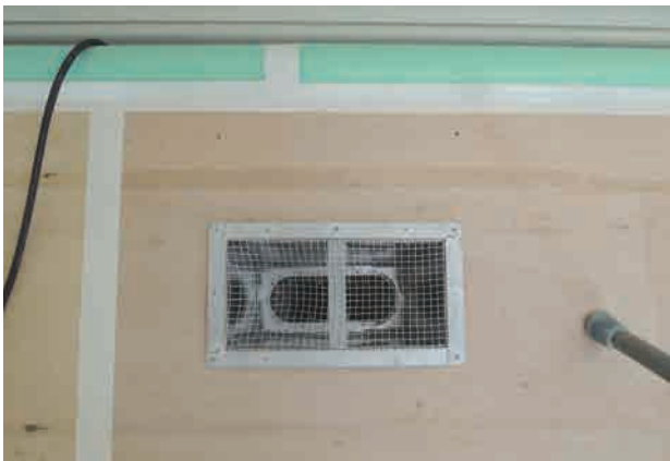
図2-4-5 仮設足場2箇所へ吸気口を設置
