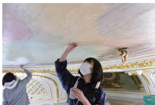
図2-4-60 キャンバス破損部接着作業風景
