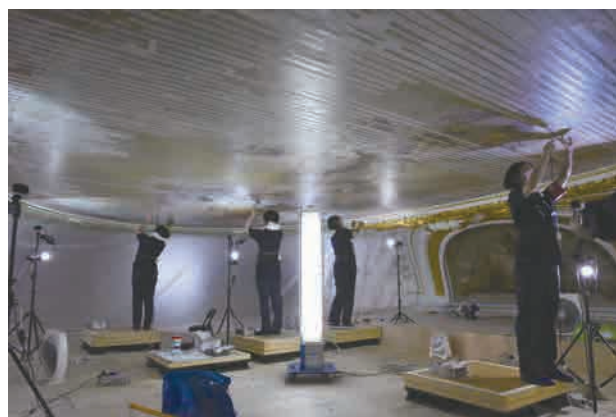
図2-4-18 浮き上がり接着作業風景
