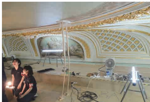
図 2-4-105 カンバス剥離再接着 圧着作業
