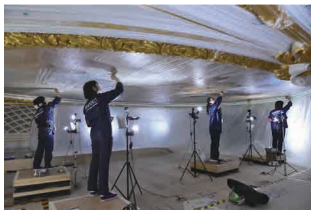
図 2-4-25 画面洗浄 第2工程作業風景
