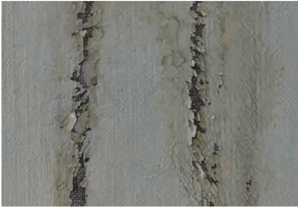
図 2-2-55 天井絵画 修復前 絵具層の浮き上がり
