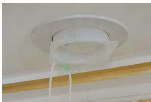
図2-4-96 保護ワニス噴霧時に専用カバーを取り付け、この上にビニールシートで養生を行った。
