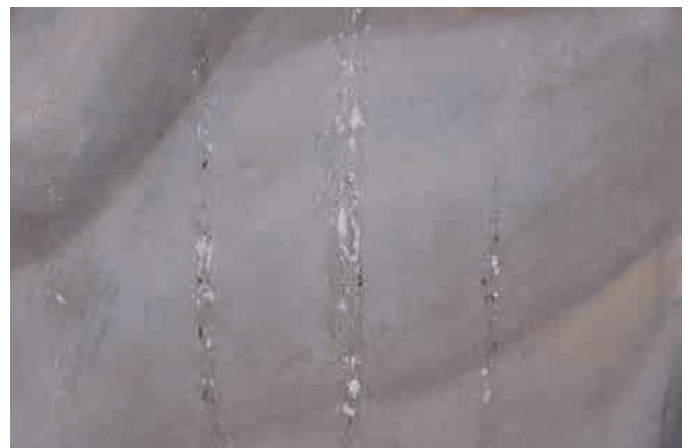
図 2-4-38 天井絵画 画面洗浄 第4工程 固着が良好な充填剤は再利用した。
