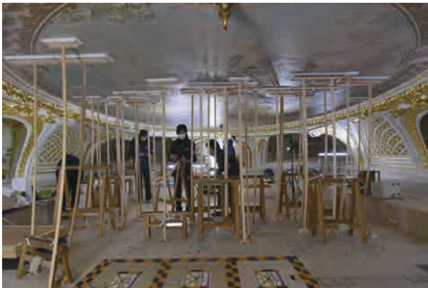
図 2-4-53 膠水が乾燥するまでつかえ棒をして圧着した。
