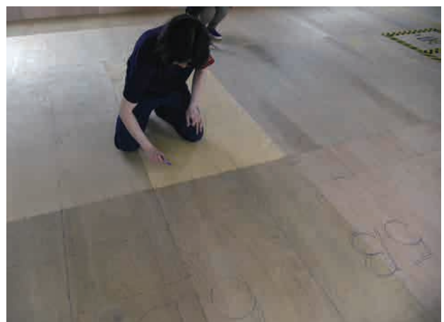
図 2-2-12 足場床面への柵目の書き込み
