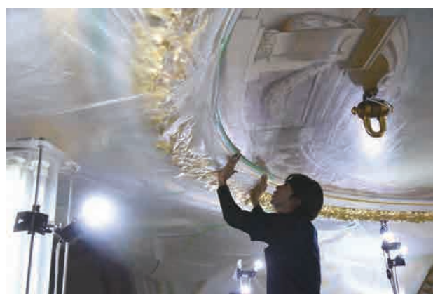
図2-4-97 天井・壁の養生
