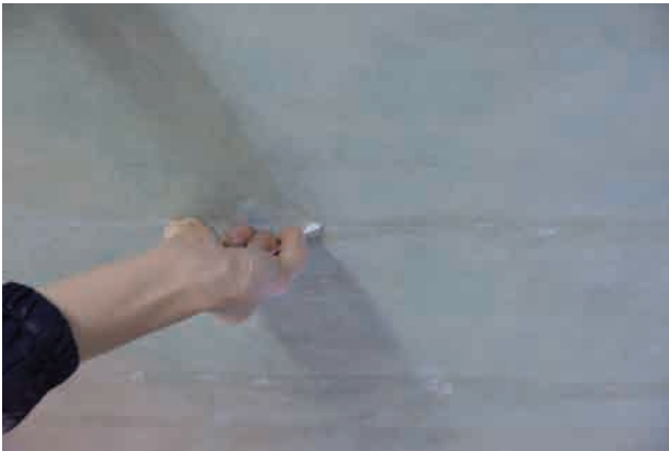
図 2-4-67 ミネラルスピリットを含ませた綿棒で充填剤を軟化させながら整形した。整形後、同様の綿棒で余分な充填剤を除去した。
