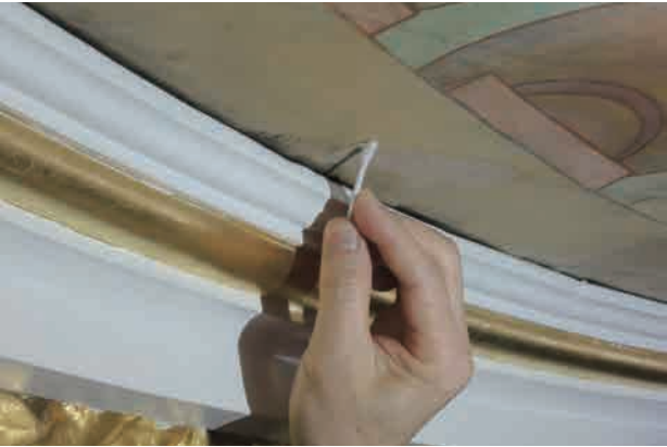
図 2-2-64 接着後、精製水で余分な膠を除去した。
