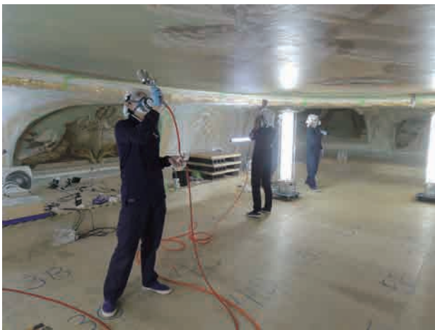
図 2-4-101 保護ワニス噴霧作業風景
