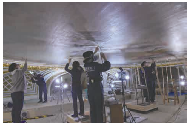
図 2-4-45 再浮き上がり接着作業風景
