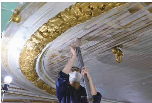
図 2-4-21 画面洗浄 第一工程 刷毛を用いて塵埃を除去した。
