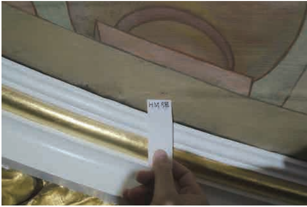
図 2-2-66 天井絵画 HM膠を用いた接着後の経過観察では、固着は良好であった。
