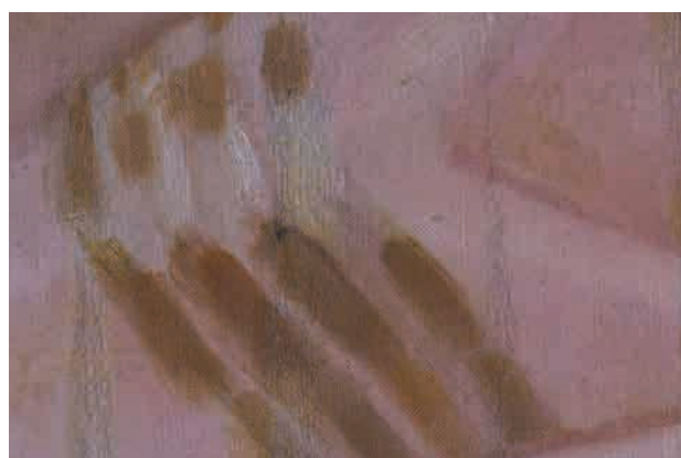
図2-2-54 天井絵画 修復前 絵具層の剥落
