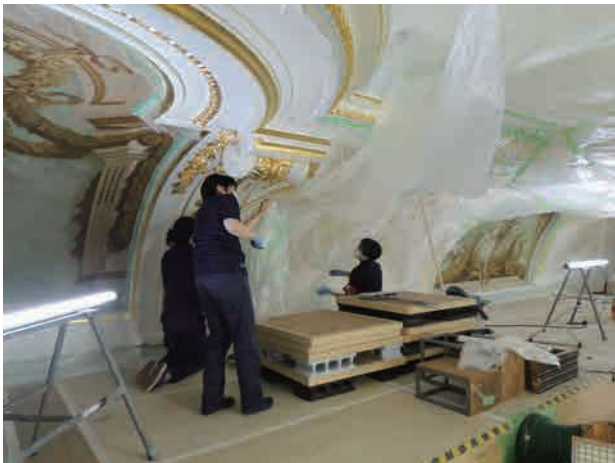
図 2-4-102 保護ワニス噴霧後、養生を取り外した。
