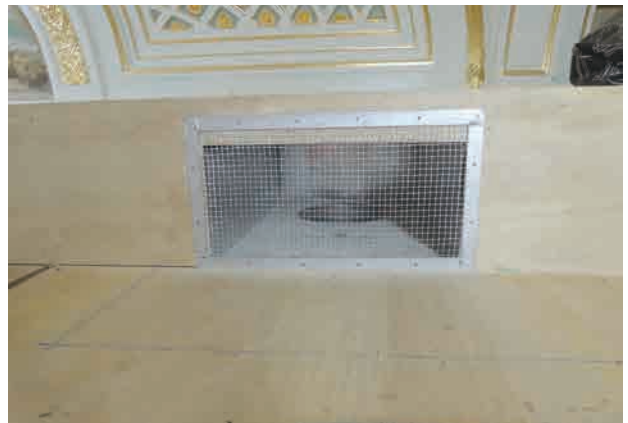
図2-4-6 仮設足場2箇所へ排気口を設置
