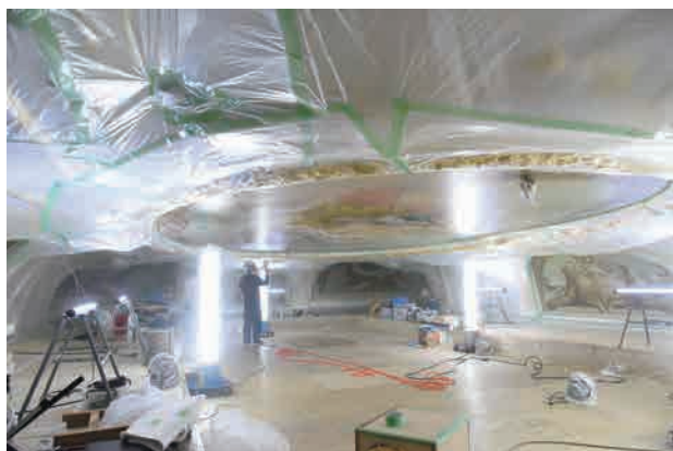
図2-4-98 天井・壁の養生後 天井絵画と壁画のみが露出した状態である。
