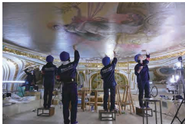
図 2-4-49 剥離を確認した箇所に、パッチ状のポリエステル紙を貼った。
